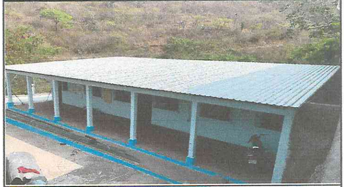
Foto 2: sustitución de lamina por lamina calibre 28
